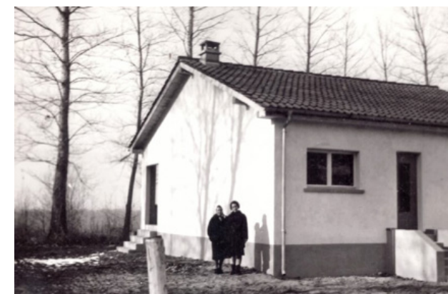
1965 pas encore d'électricité – noch ohne Strom.
